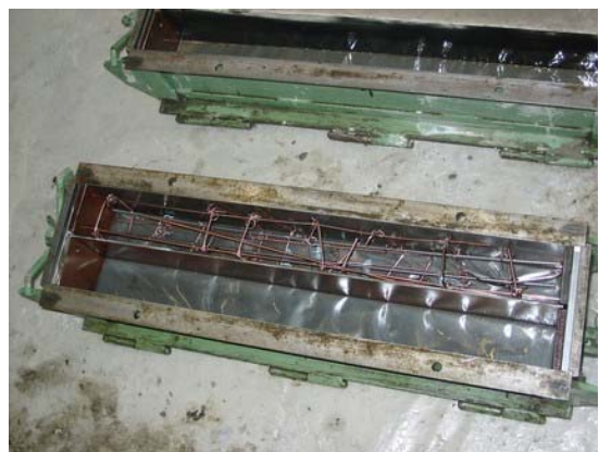
Bewehrung in Schalung
