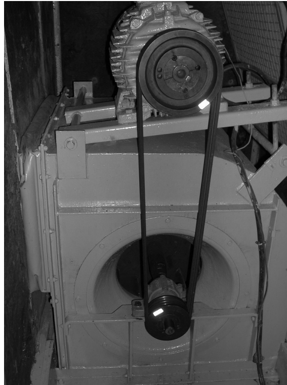
Bild 3.1 Klimalüfter auf einem Kreuzfahrtschiff
